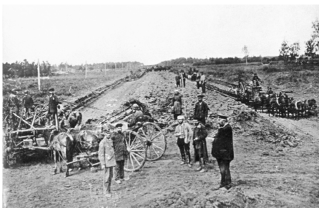
Строительство железных дорог в Беларуси, www.rw.by
